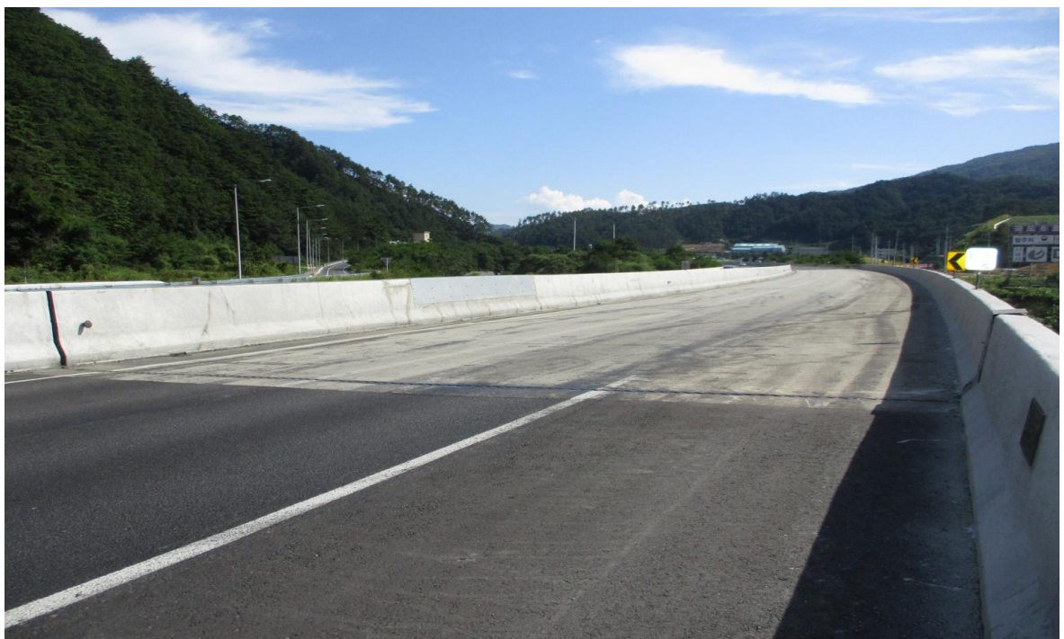
교량 상부 전경
